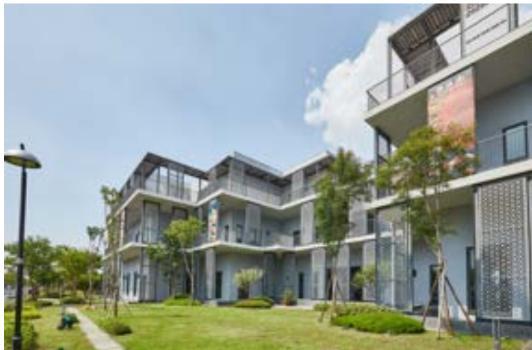
舊振南綠建築總部
