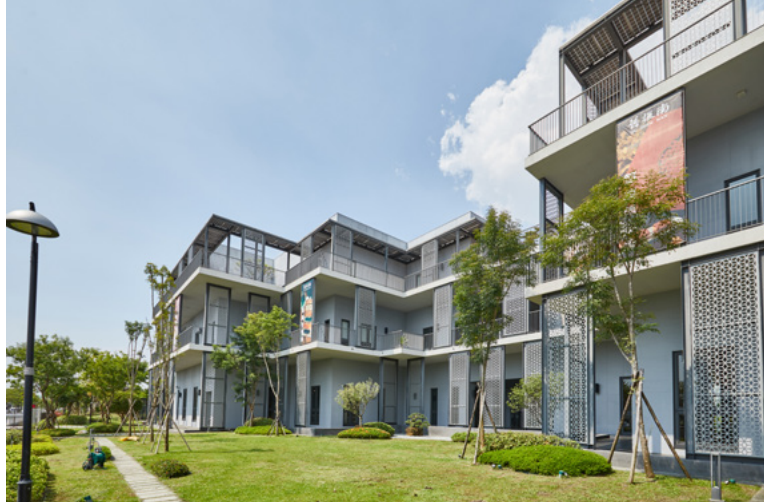
舊振南綠建築總部
